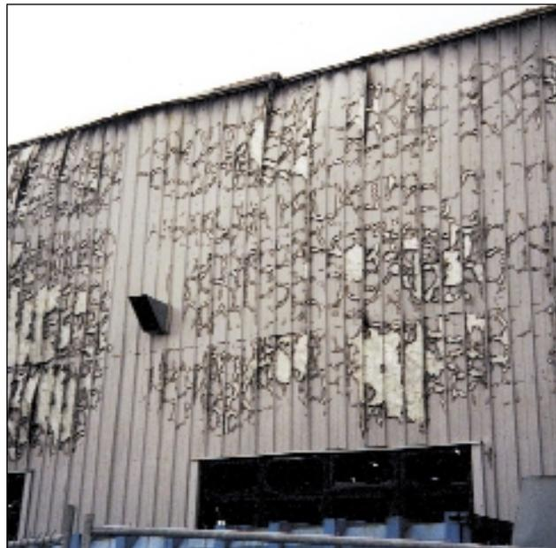
*Le revêtement du mur PIR est resté intact lors de cet incendie bien que charpente se soit totalement désintégrée.*
